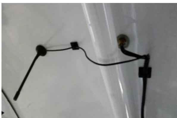
Bild 14: Montage WIFI-Antenne Dach-innenseite
